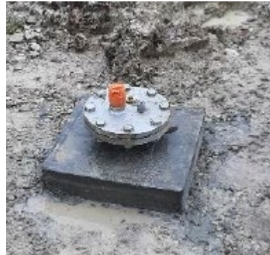
Mise en place de la bride fermée en tête de forage
